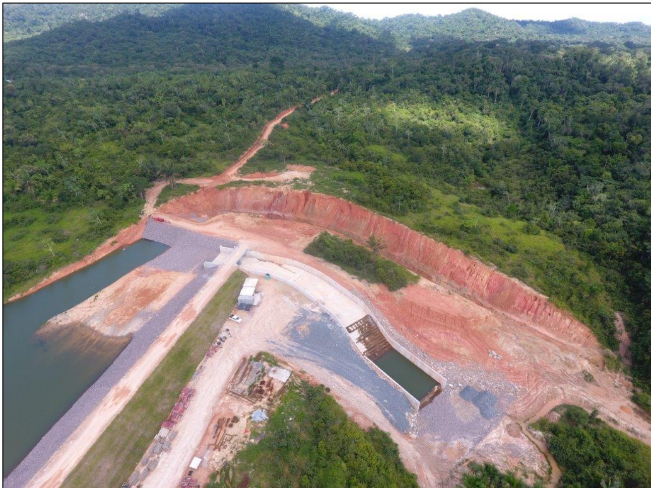
Foto 1.2 – Barragem de água de Aripuanã – Vista superior da ensecadeira e do canal de desvio (Fonte: Mineração Dardanelos, 2021).
