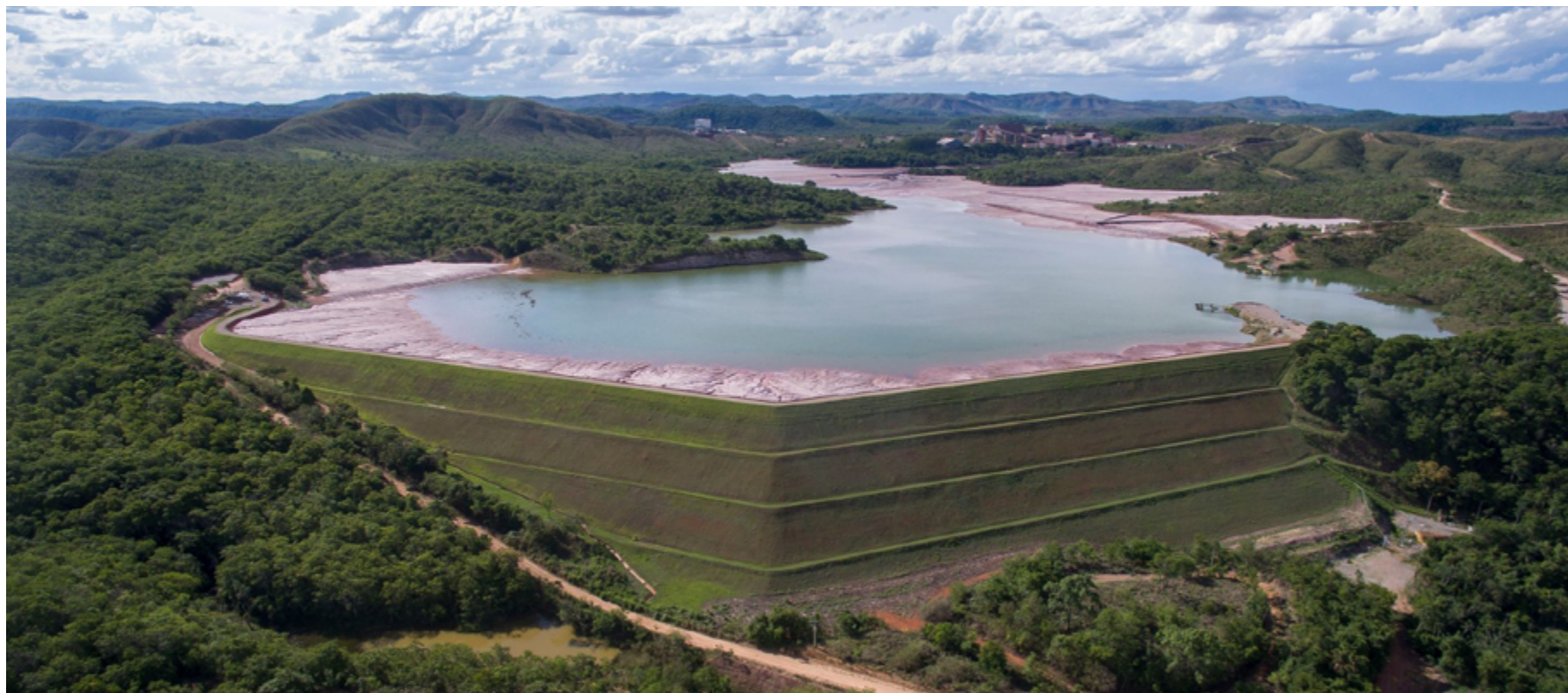
Presa de Aroeira, ubicada en la unidad de Vazante (Brasil)
