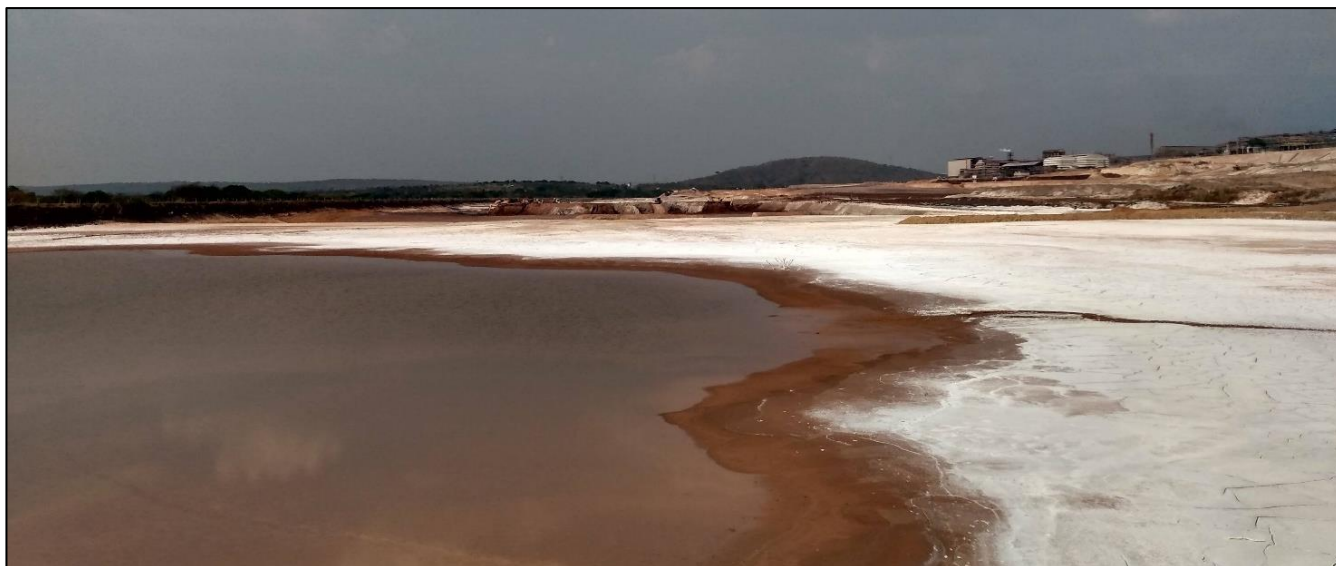
Figura 2.2 – Foto do reservatório do Dique de Segurança.
