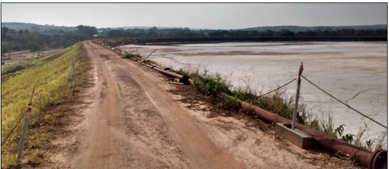
Figura 2.1 – Vista da crista do Dique de segurança.
